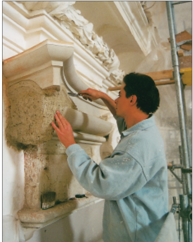
Abb. 1: Rekonstruktion eines Kapitells, Grundaufbau der Volute
